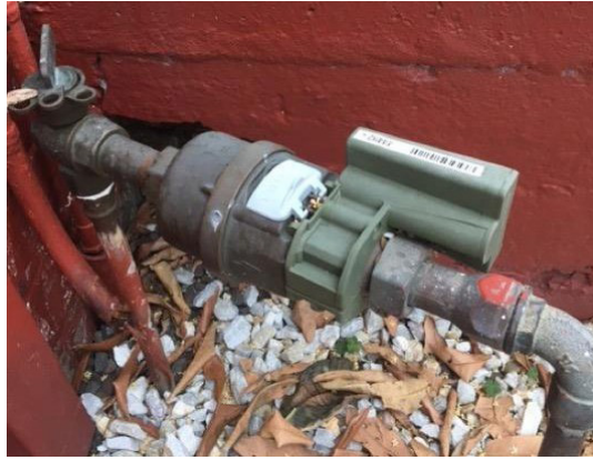
Gambar 4. Ilustrasi unit Smart Water Meter yang dipakai di Port Macquarie-Hastingscouncil, Australia
